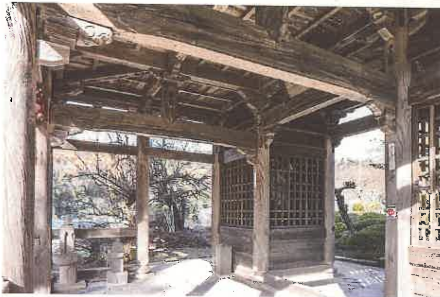
一階内部北西面
