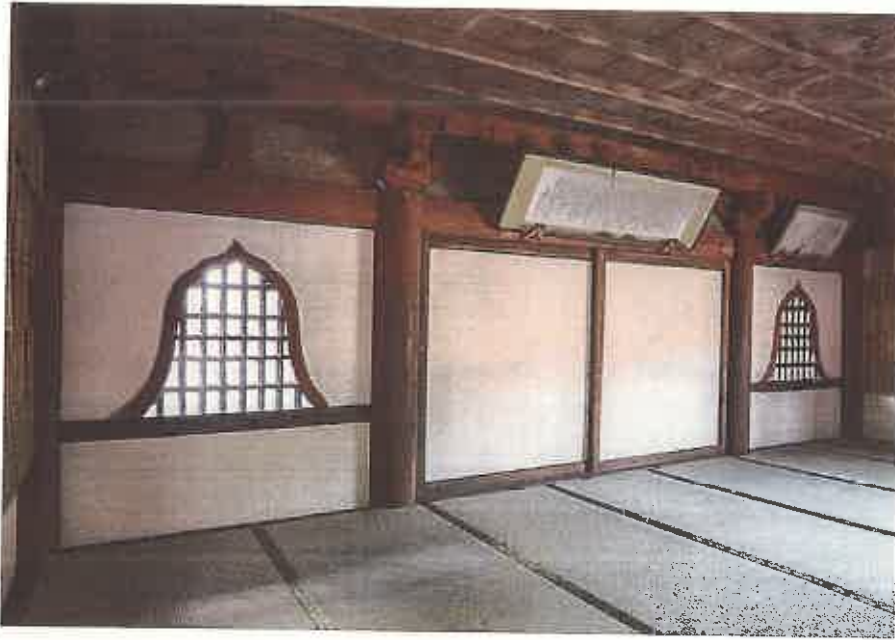
二階内部南面
