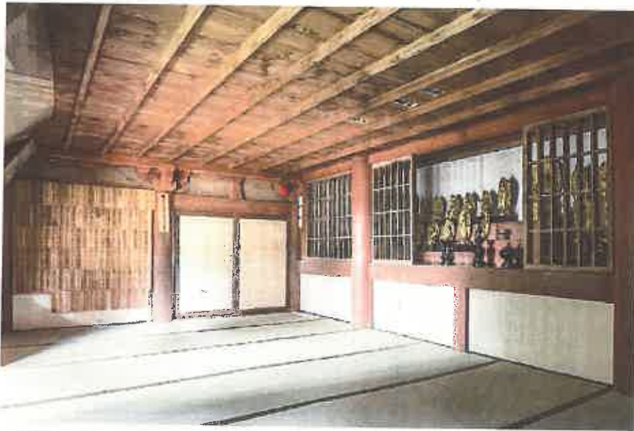
二階内部北西面
