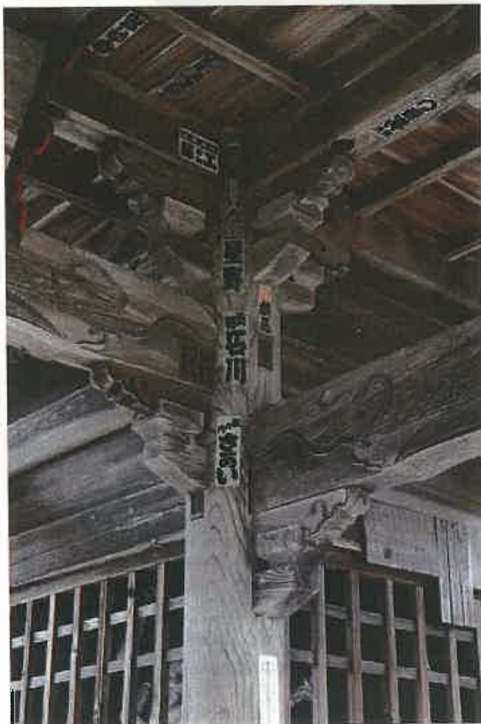
一階通柱・組物・虹梁
