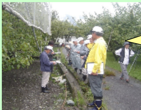
水路の機能診断と補修技術の研修会
