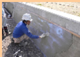
■ 水路の老朽化箇所 の補修
