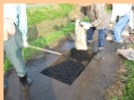
■ 農道舗装の補修
