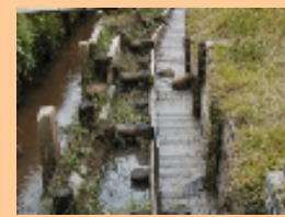
■ 水田魚道の設置
