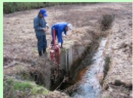
■ 点検・機能診断
