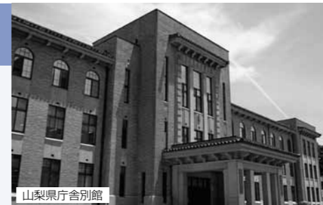
山梨県庁舎別館
