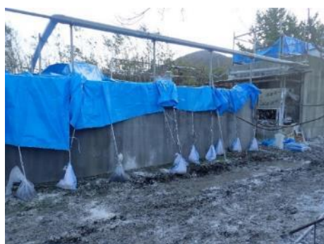
図11. 浄化槽封じ込め
