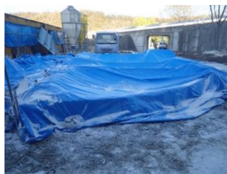
図12. 浄化槽封じ込め
