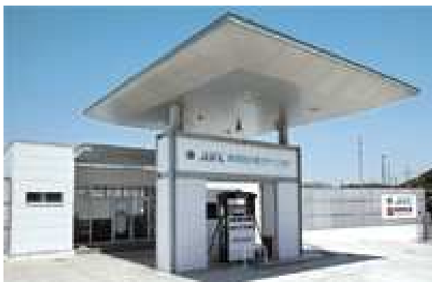
水素ステーション
