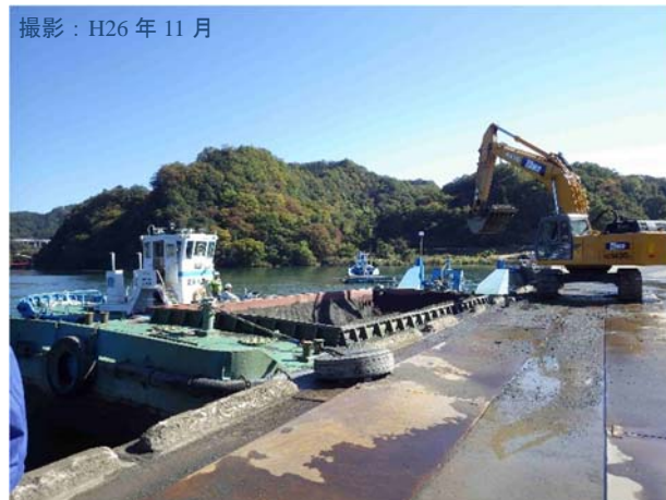
写真 2.2.2 相模ダム浚渫の実施状況
