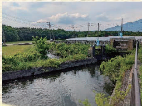
桂川分水 水門ゲートで水量が調整される
