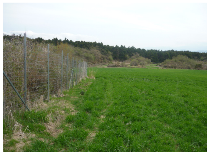
完成後 柵高H=2.3mの鳥獣害防止柵を設置し、 シカの侵入を防ぎ、被害の軽減を図った。
