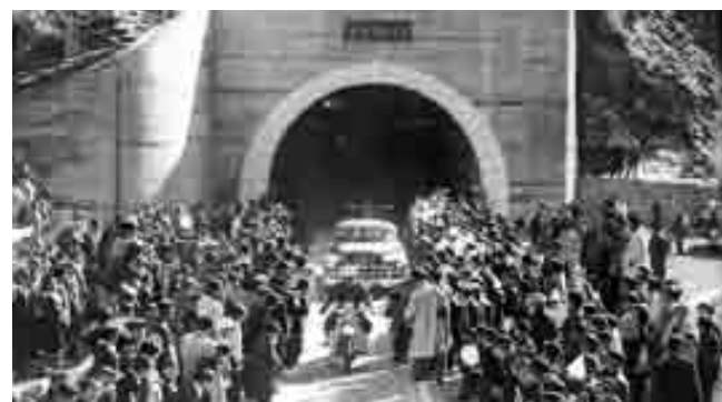
新笹子トンネル開通
