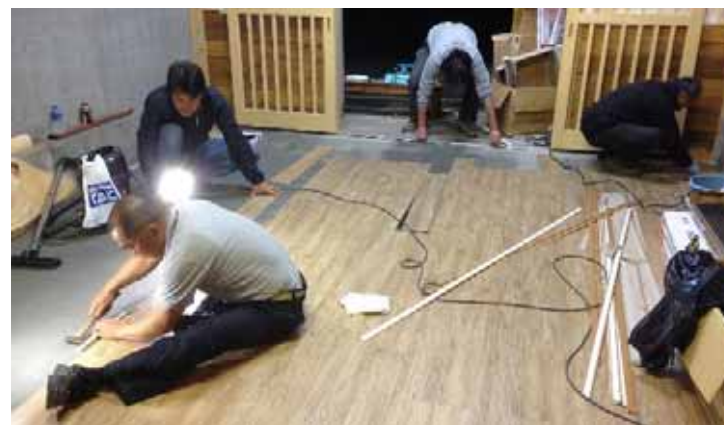
・メンバー自らによる改築作業
