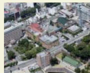
急がれる県庁舎耐震化整備
