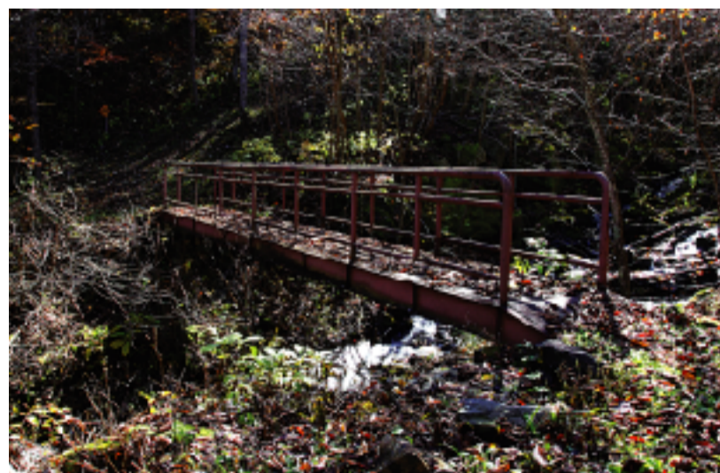
周囲の風景に不思議と溶け込んでいる小さな鉄製の橋。
