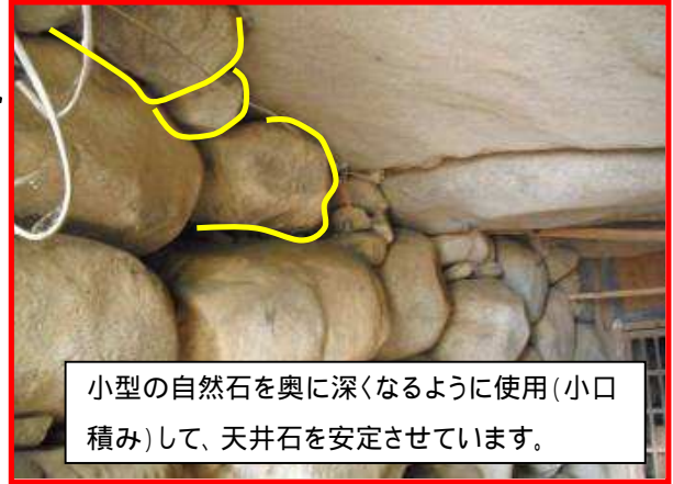
【 左側壁と天井の接続状況 】
