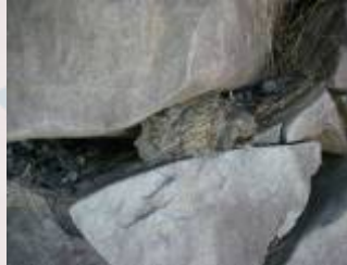
破損詰石除去交換
