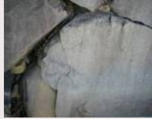
石材表面破損部除去
