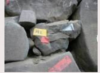
石材破損交換
