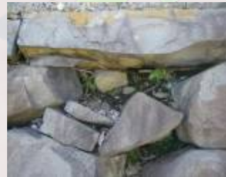
詰石欠落詰石補充
