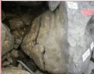
石材前後破断補強
