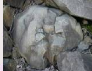
石材破損補強
