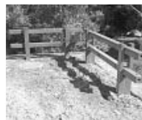
写真 転落防止柵
