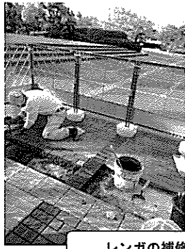
レンガの補修
