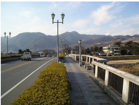
根津橋 都市計画道路・根津橋通り線 眺望景観を確保するスペースを設けるとともに、高欄や照明、歩道舗装に配慮した。
