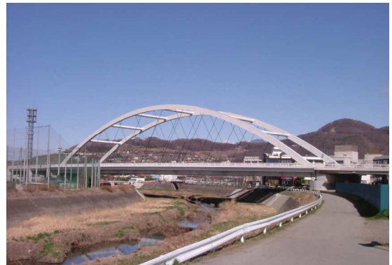
城東大橋 国道140号 優雅な曲線を描くアーチ橋とし、周辺との景観に配慮した。
