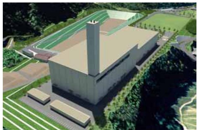
図 5-2-1(6) ごみ処理施設イメージ図 (煙突位置：北東端、煙突高さ：100m)
