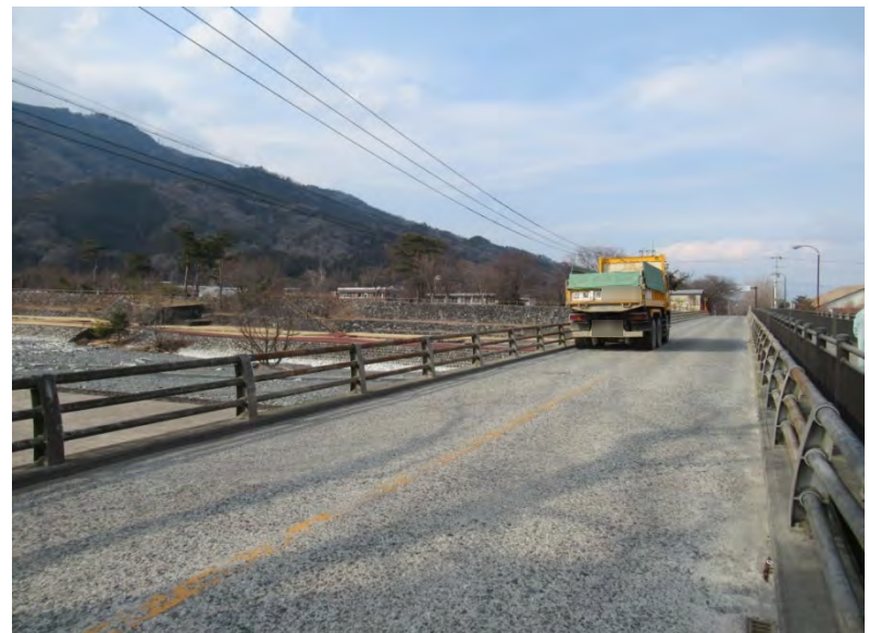
④幅員狭小状況
