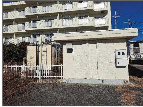
は・に棟ポンプ小屋
