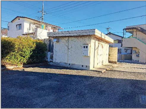
い・ろ棟ポンプ小屋
