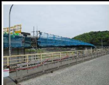
富士橋(建設中)
